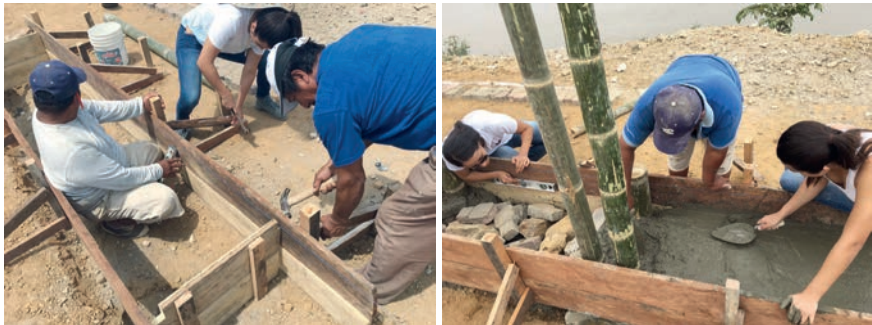
Figura 21. Ejecución de la construcción del área recreativa
