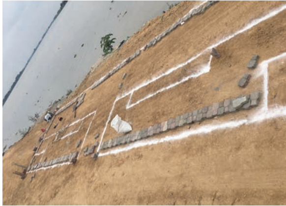
Figura 20. Limpieza y replanteo del área
